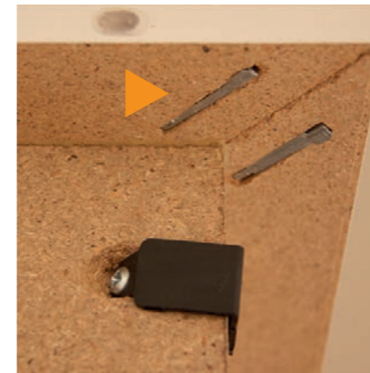
preciese sluiting van het verstek van de deurlijsten d.m.v. regelbare klipsen
