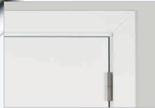
kozijn met deurlijsten in verstek cadre avec chambranles en onglet
